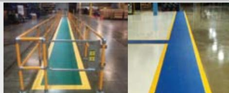
OSHA-Code 1910,22 (b) (2) erfordert permanente Gassen und Durchgänge, die entsprechend gekennzeichnet sein müssen. Diese Bodenmarkierungen sind eine schnelle und kostengünstige Lösung um die Fußgängerbereiche vom Verkehr und von schweren Maschinen zu trennen.
